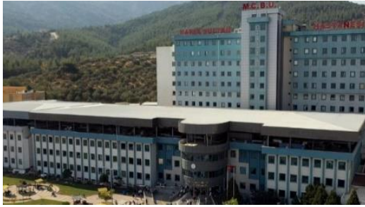
Resim 1 Hastane Çatı Görünüşü
